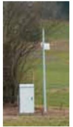
Der fünf Meter hohe Mastbaum mit einer 30 cm-Parabolantenne kann später alle Bauparzellen des Industriegebietes über Glasfaserkabel versorgen. Die Anlage wird vom Sender am Kronberg aus mit einer geringen und in keinsten Weise gefährlichen Leistung von nur 125 Milliwatt gespeist.
