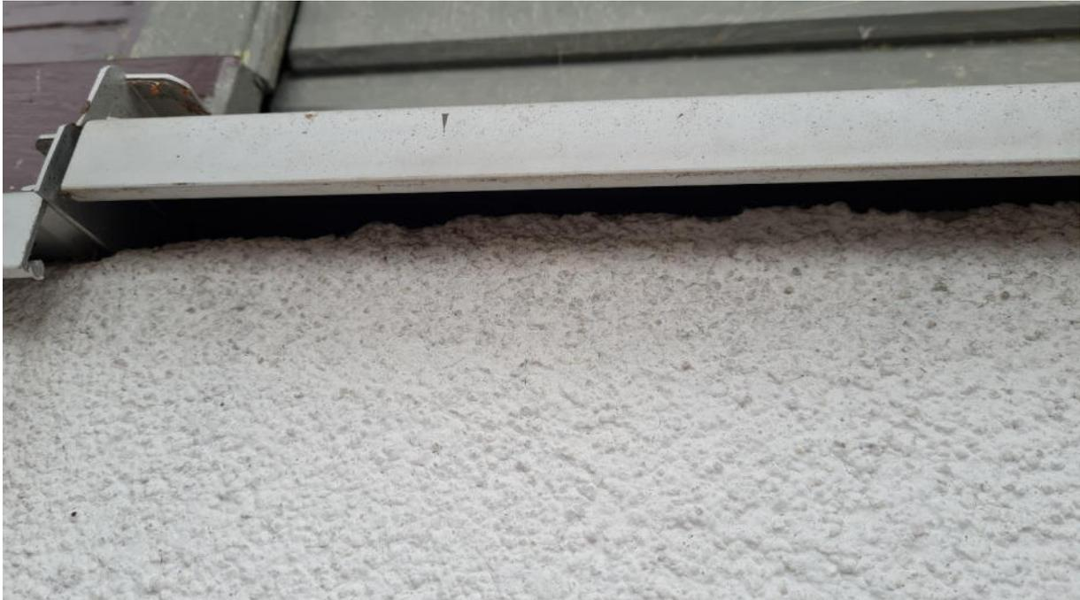
Abbildung 3: Mauerabdeckung mit Einschluþmöglichkeiten für Fledermäuse
