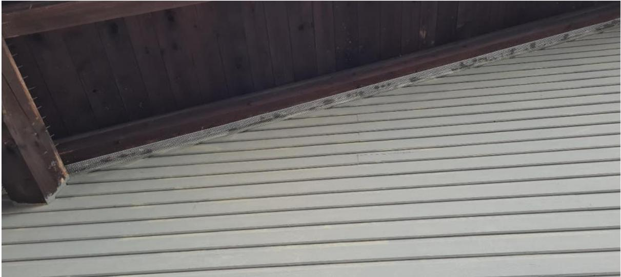
Abbildung 8: Die Verbretterung ist dicht, an vielen Stellen sind Gitter angebracht
